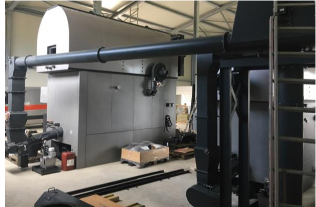
Heizzentrale in der Montagephase
